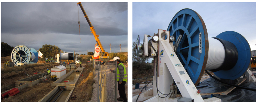
Rys. 3. Układanie linii INELFE, listopad 2013 (fot. autorka)
